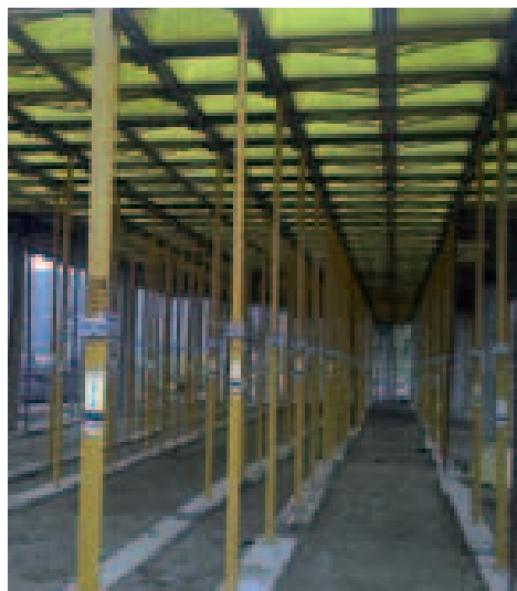
Puntal SP apeando Encofrado Cubetas RECUB en el Centro tecnológico de OVAR, Portugal
